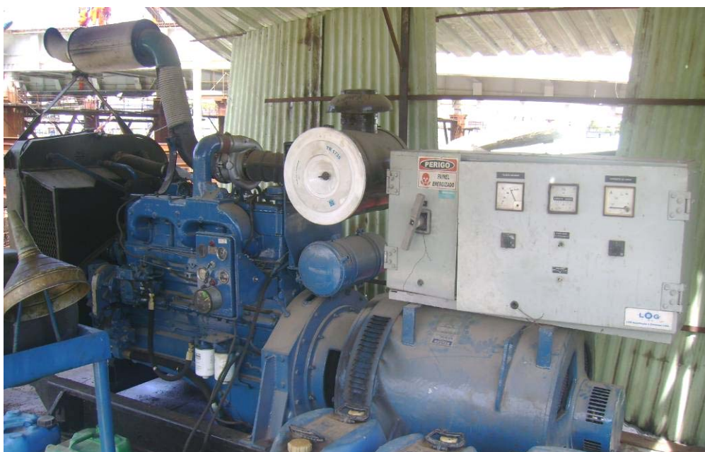
Figura 5.4 – Gerador utilizado como fonte de energia para soldagem.
