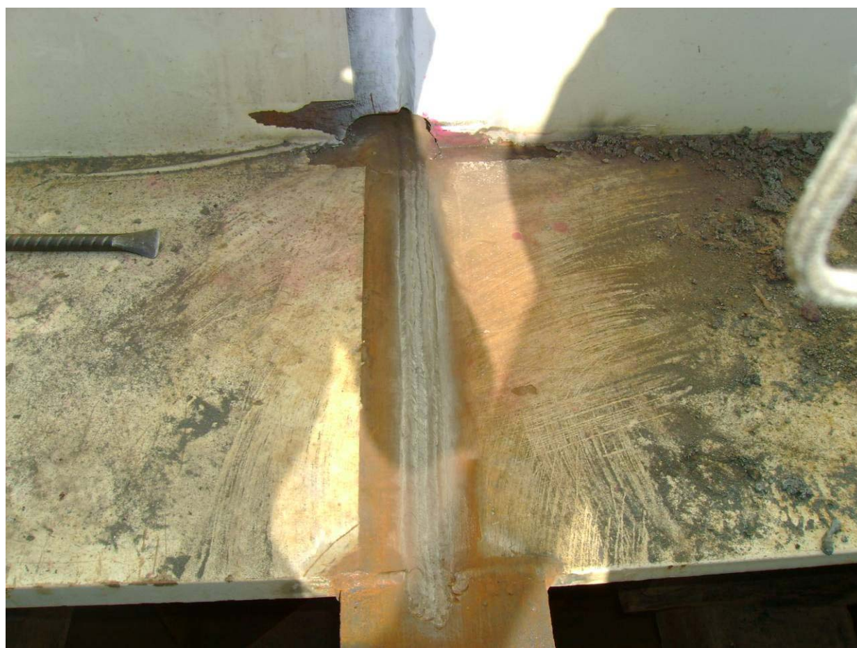
Figura 5.14 – Inspeção visual após a soldagem.
