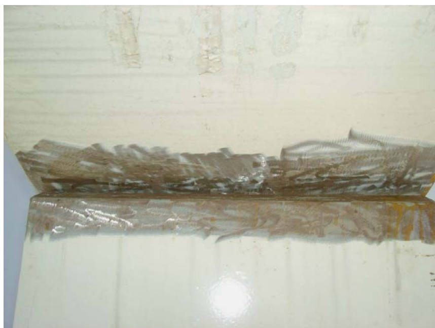
Figura 5.9 – Remoção da pintura por esmerilhamento para execução da solda.
