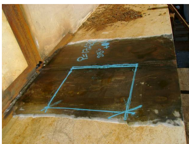
Figura 5.18 – Indicação das descontinuidades encontradas na solda.
