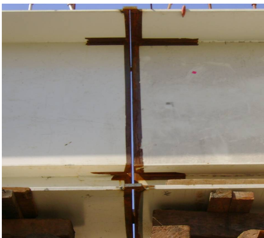
Figura 5.12 – Junta preparada para início da solda.
