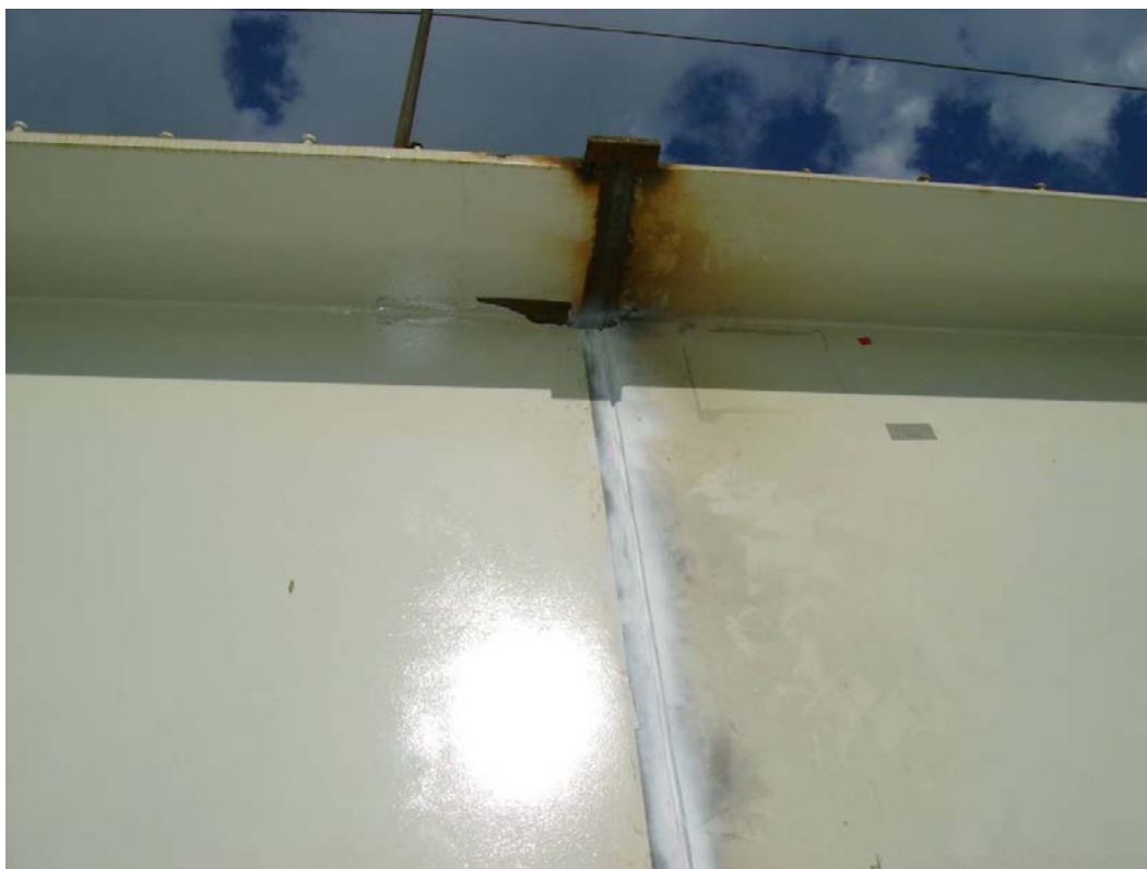
Figura 5.15 – Realização do ensaio de líquido penetrante entre os passes de solda.
