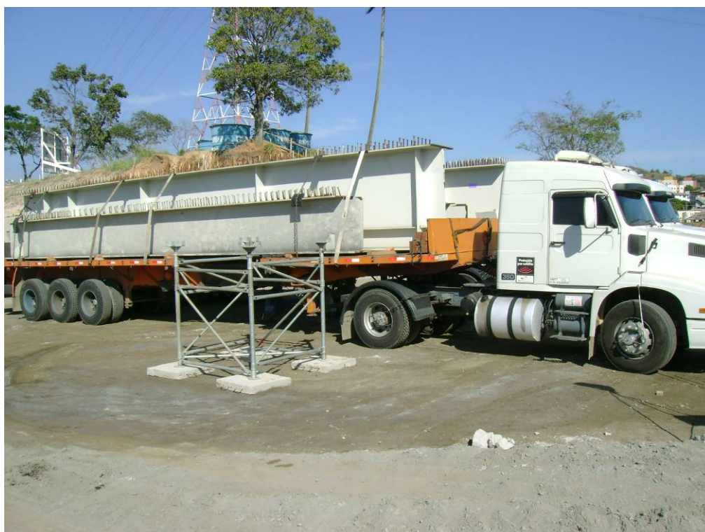
Figura 5.2 – Longarinas e transversinas sendo transportadas da fábrica até o local da obra
