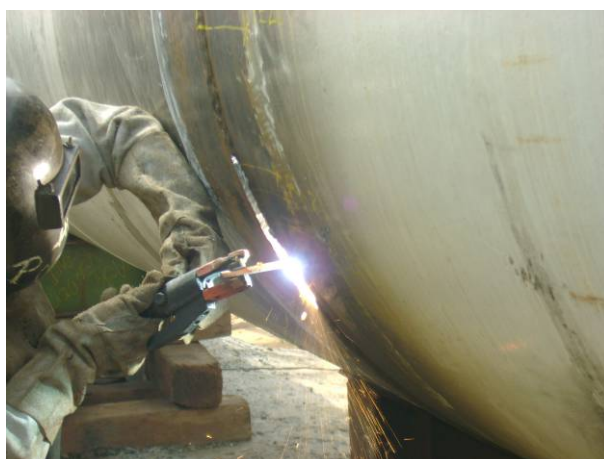
Figura 5.19 – Remoção da solda para reparo dos defeitos encontrados.
