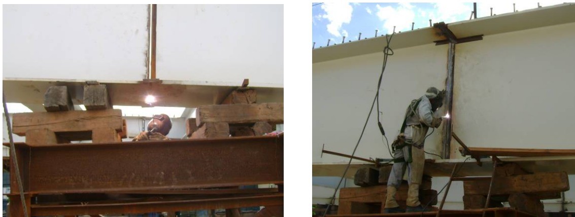
Figura 5.10 – Soldagem das juntas entre as longarinas.
