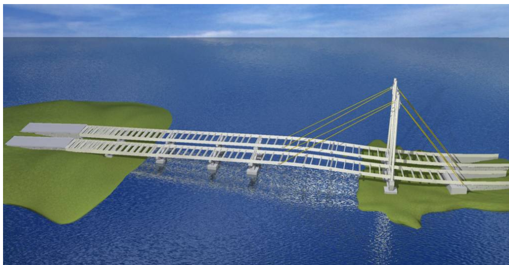
Figura 5.1 – Vista geral da estrutura metálica da ponte.
