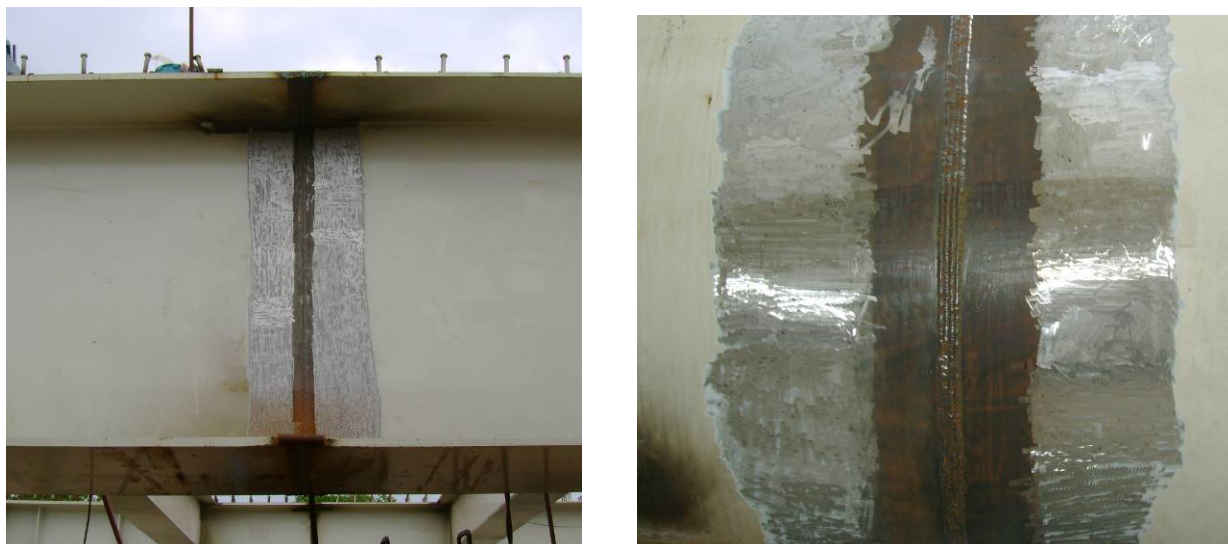
Figura 5.16 – Remoção do revestimento para realização do ensaio de Ultra-Som
