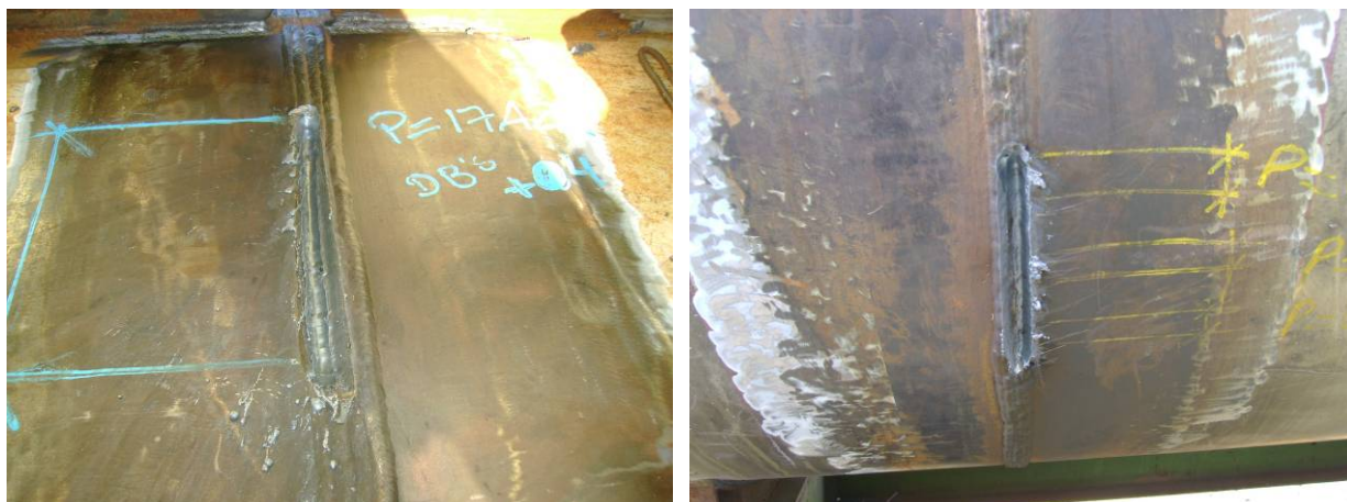
Figura 5.20 – Remoção da solda para reparo dos defeitos encontrados.
