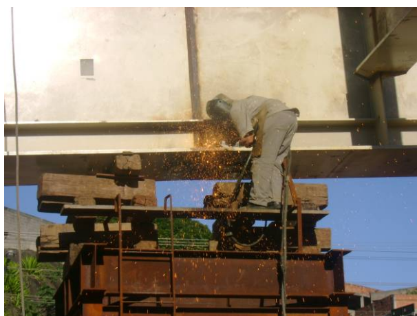
Figura 5.19 – Remoção da solda para reparo dos defeitos encontrados.
