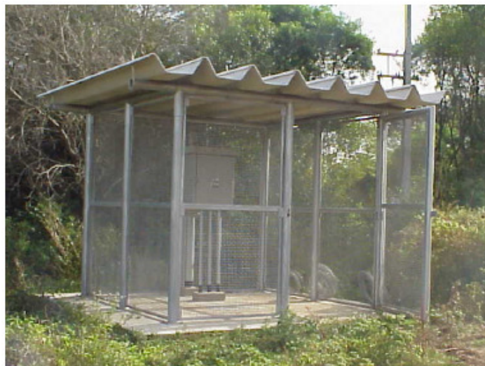
Figura 3.6 – Exemplo de Retificador
