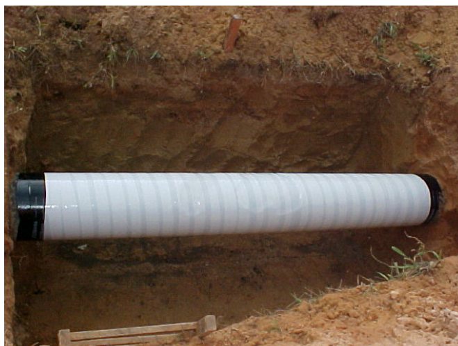
Figura 7.3 – Duto revestido com luva Epóxi.
