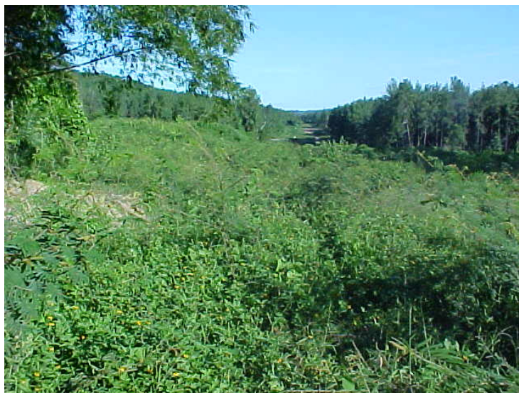
Figura 7.1– Duto enterrado em região de mata fechada.
