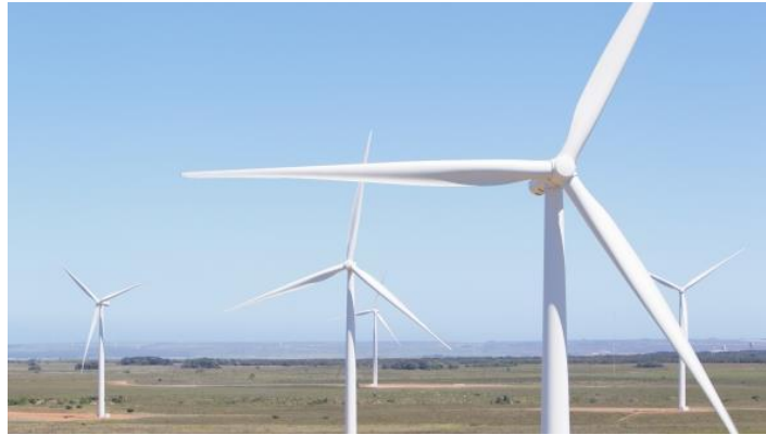
Figura 1 - Turbina eólica de eixo horizontal SWT-2.3-101, fabricante Siemens
