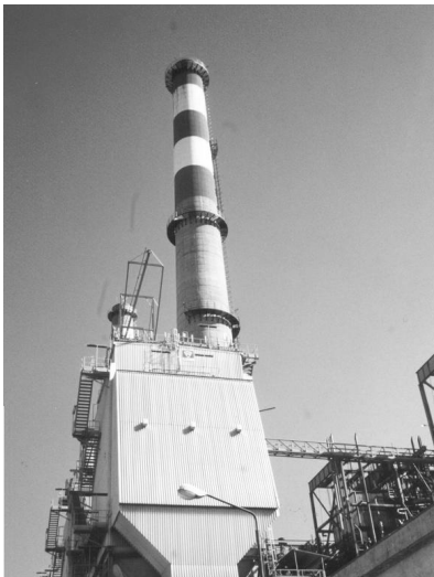
Figura 1 - Exemplo de chaminé Industrial Metálica
