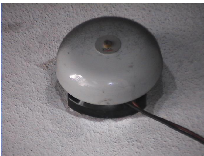
Figura 17 – Indicação de baixo nível de água no interior da caldeira
