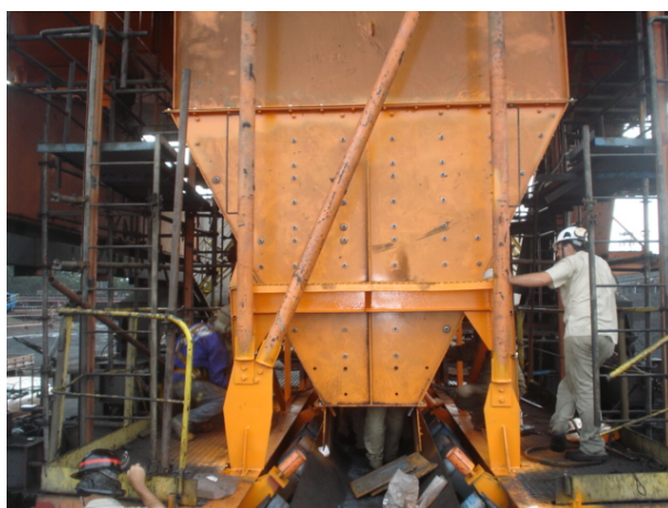
Figura 3.12 – Chute Central e Mesa de Impacto.
