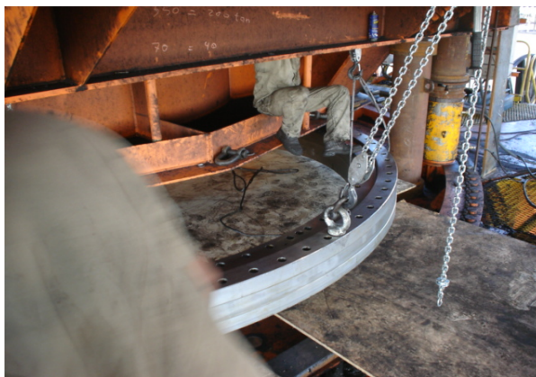
Figura 4.22 – Posicionamento do Rolamento sobre o leito.
