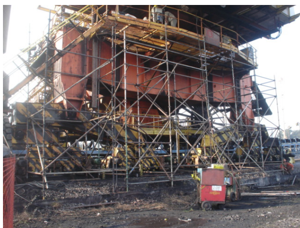
Figura 4.12 – Andaime montado para a retirada do rolamento antigo e posicionamento do novo.
