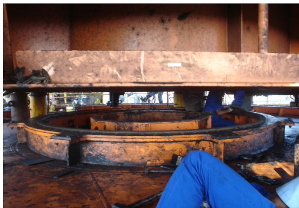
Figura 4.16 – Estrutura suspensa cerca de meio metro acima da posição inicial.
