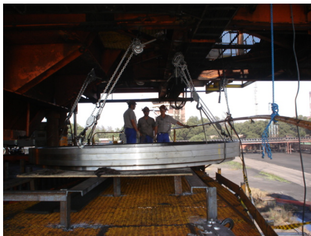
Figura 4.21 – Rolamento novo posicionado sobre a estrutura inferior da recuperadora.
