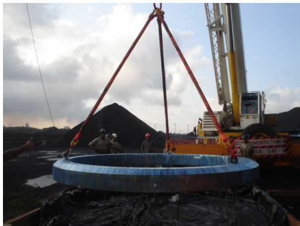
Figura 4.20 – Içamento do rolamento novo pelo guindaste até a posição sobre a mesa inferior da recuperadora.
