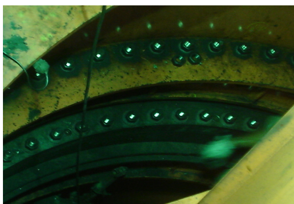
Figura 4.24 – Torquiamento dos parafusos e tirantes de fixação do rolamento nas estruturas inferior e superior do equipamento.
