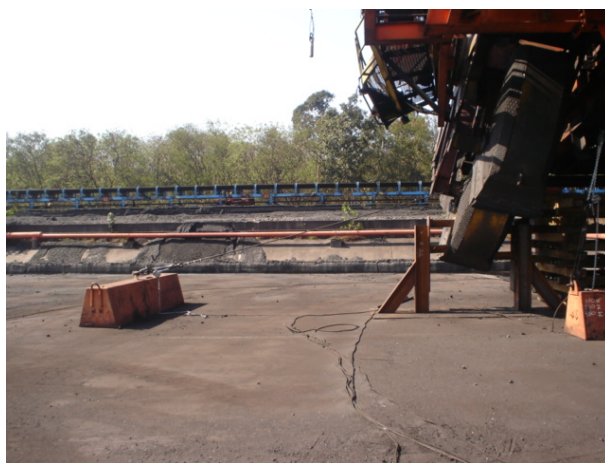
Figura 4.13 – Estaiamento da Lança da recuperadora segundo o Plano de Rigging.
