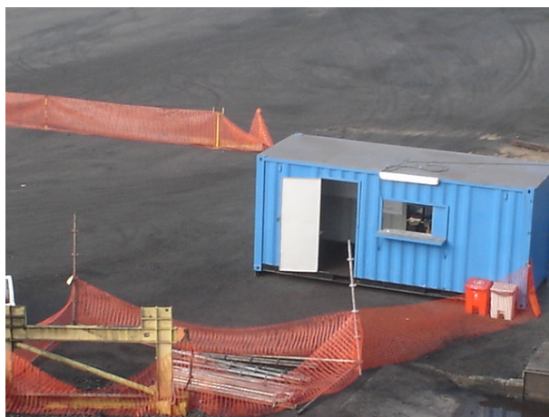
Figura 4.6 – Contêiner para centro de vivência do canteiro de obras e depósito de ferramentas.
