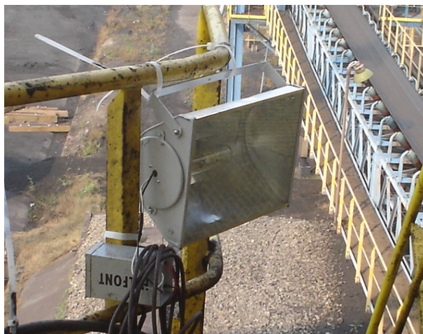
Figura 4.7 – Luminárias instaladas no equipamento para realização de serviços noturnos.
