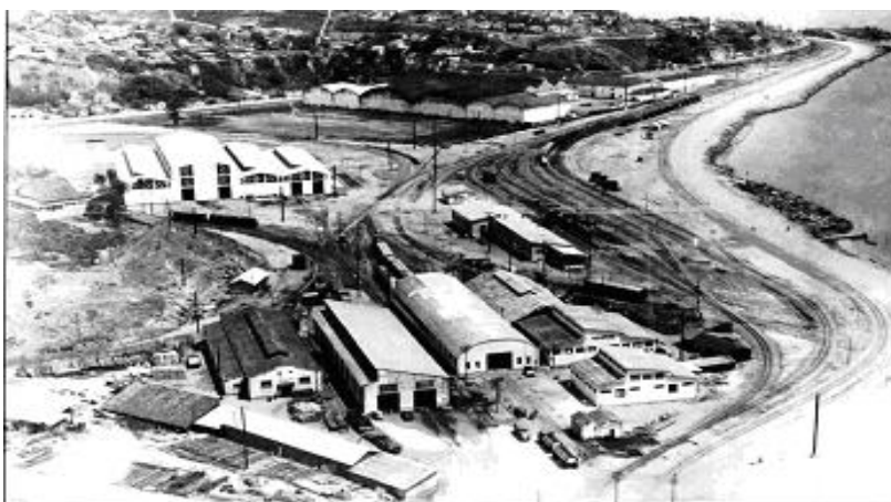
Figura 5 - Nova oficina diesel da EFVM, em Porto Velho em 1961 Fonte: Acervo da VALE
