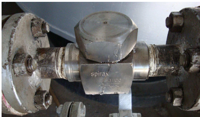
Figura 30 – Purgador termodinâmico.
