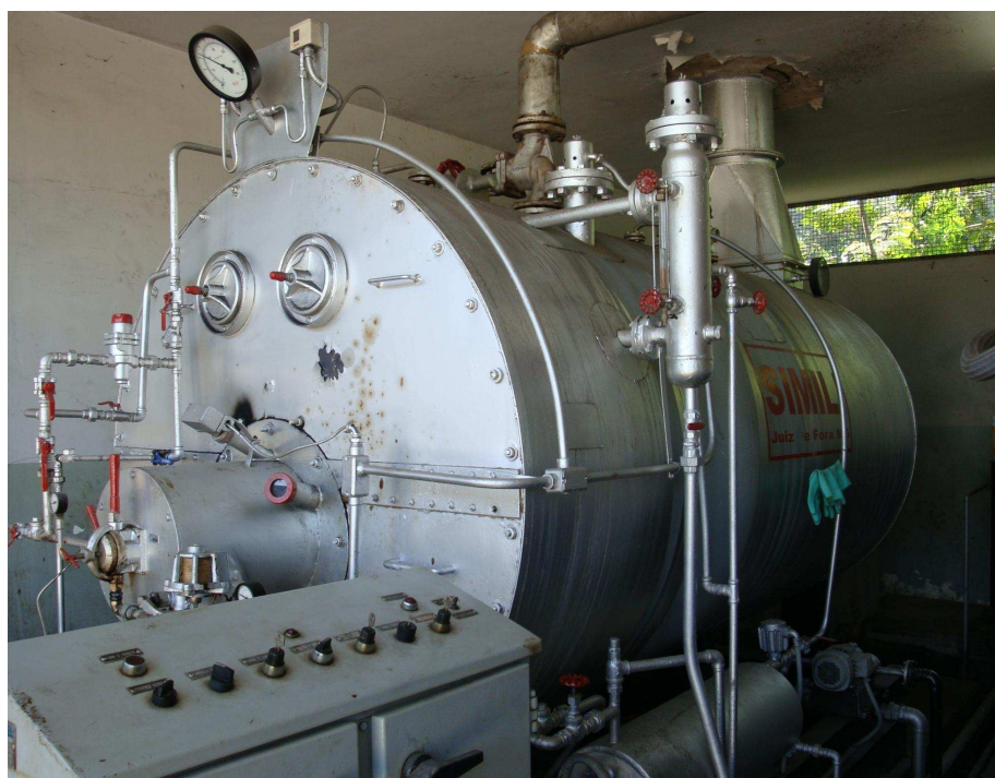
Figura 26 – Caldeira Flamotubular.
