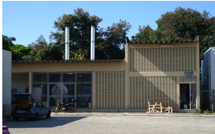
Figura 25 – Casa de Caldeiras.
