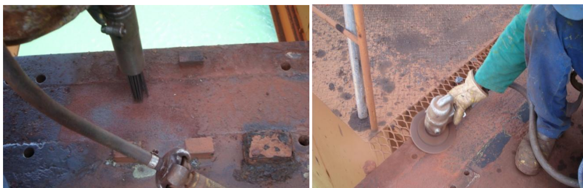
Figura 2 – Pistola de agulhas (à esq.) e lixadeira rotativa atuando no tratamento de superfícies de aços estruturais em um carregador de navio.
