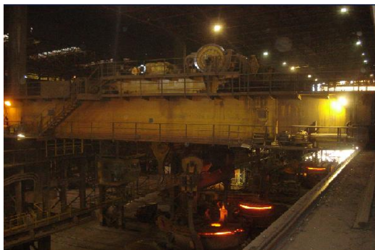
Figura 14 - Viga da ponte 08 e carro (trolley). Fonte: Arquivo ArcelorMittal Tubarão, 2010
