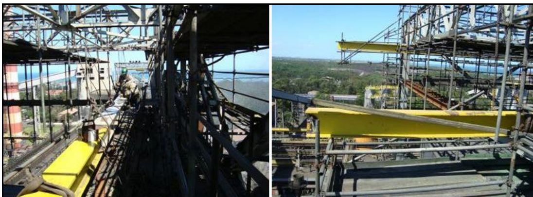
Figura 4.9 - Recuperação e posicionamento das monovias de rolamento da talha.
