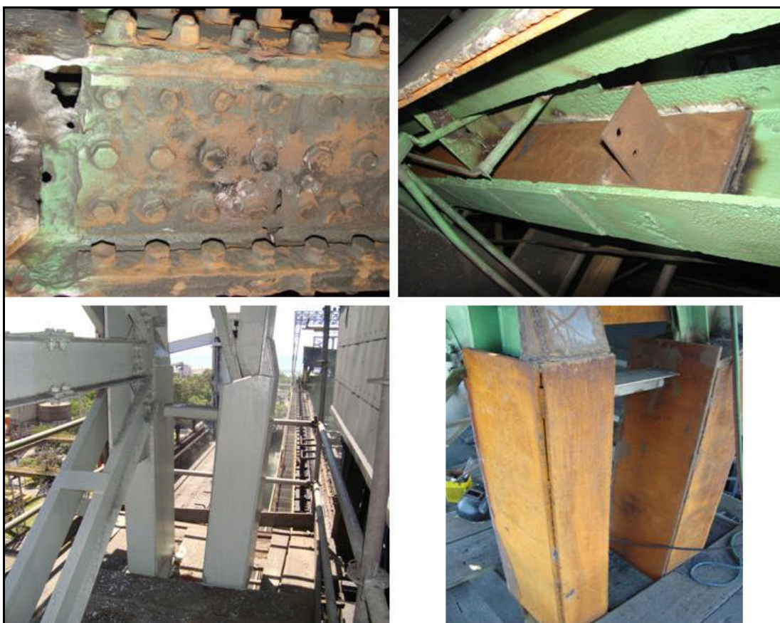
Figura 4.10 - Reforço estrutural e acabamento final das colunas principais da estrutura.
