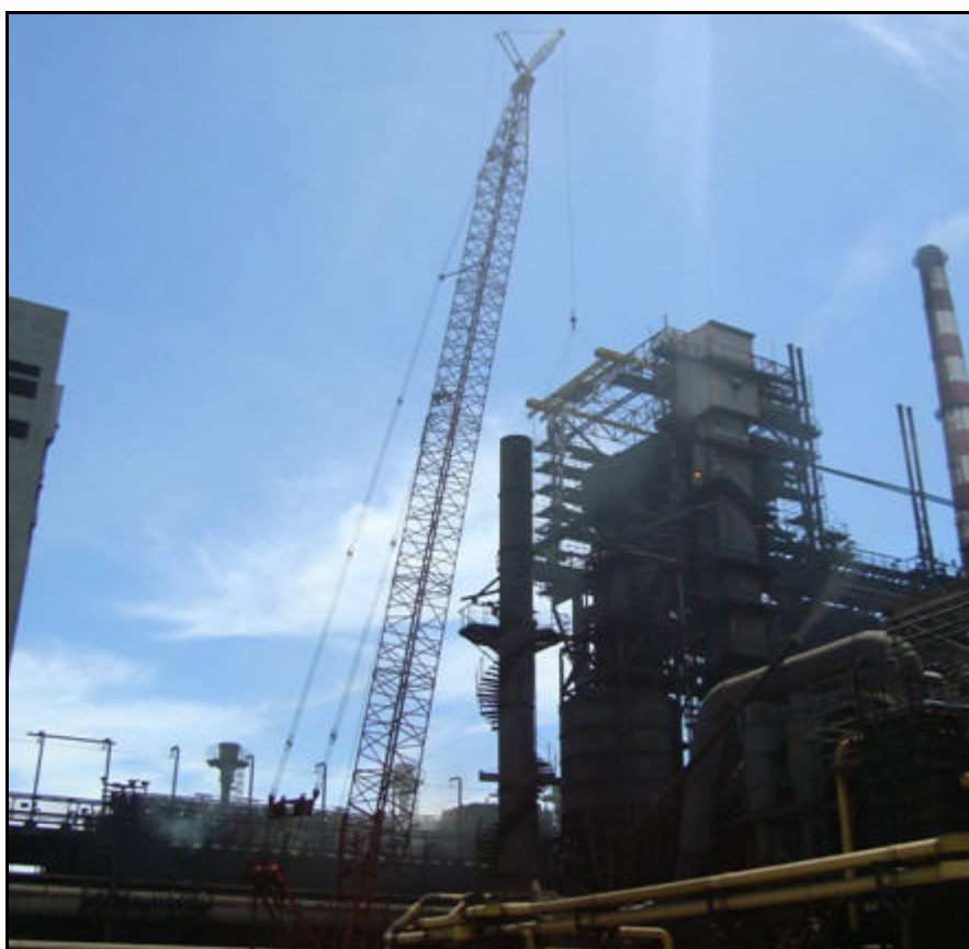
Figura 4.4 - Detalhe da lança do guindaste Manitowoc 180 t, auxiliando durante a reforma da Talha 12PR06.
