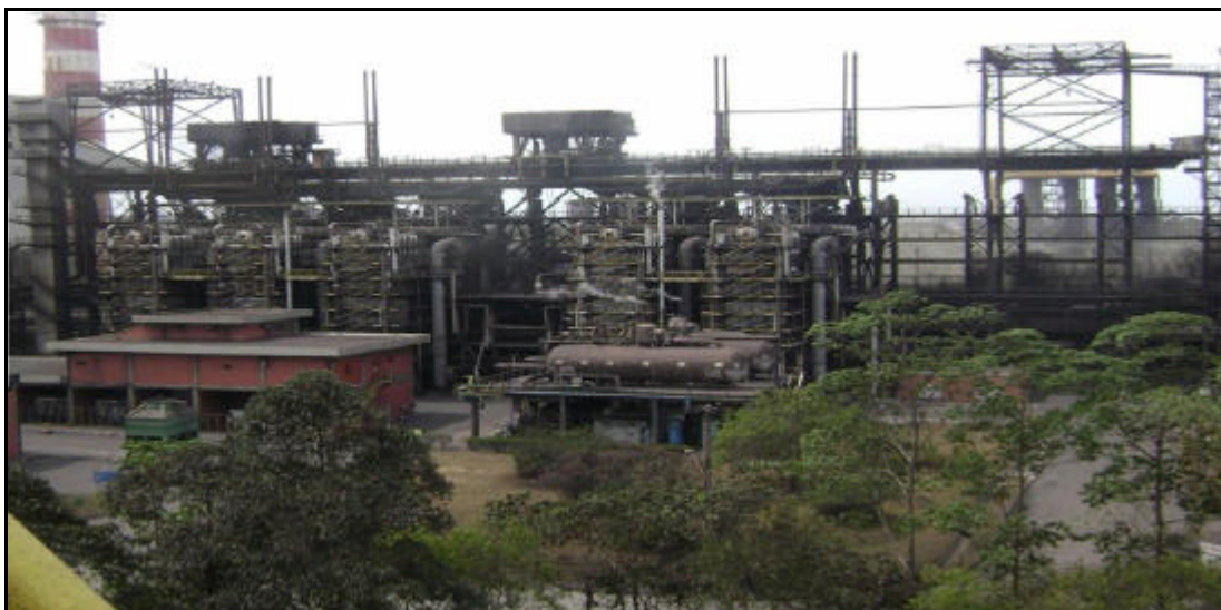
Figura 4.1 - Estruturas do Apagamento de Coque Seco da ArcelorMittal Tubarão.
