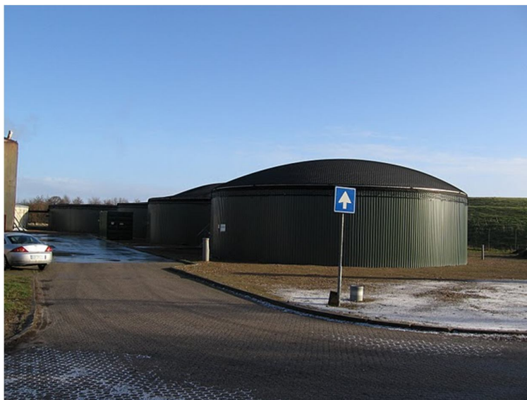
Figura II-2. Silos de digestores anaeróbicos.
