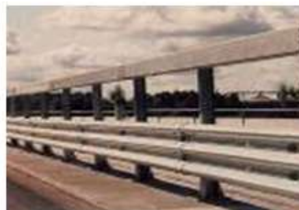
Figura 15: Bobinas Novas e uma Barreira de Proteção certificada pela EN 1317 em uma Rodovia
