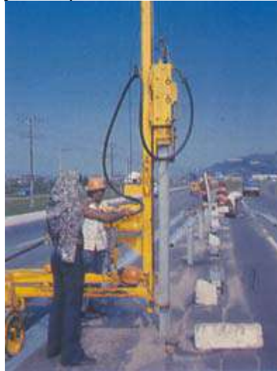
Figura 10: Instalação de postes de defensas metálicas.
