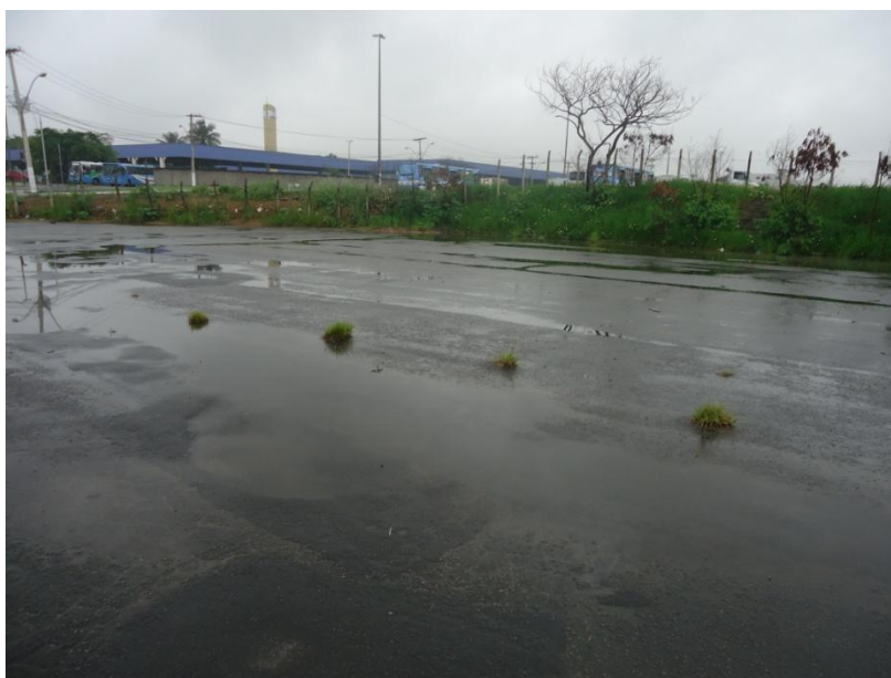
Figura 16 - Estacionamento próximo ao terminal de laranjeiras na Serra-ES, a presença de poças após o dia chuvoso denuncia irregularidades e presença de buracos na pavimentação, também é visível a presença de vegetação.
