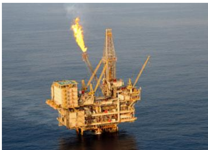
Figura 2.1 - Gás de flare sendo queimado em uma plataforma de exploração de petróleo e gás.
