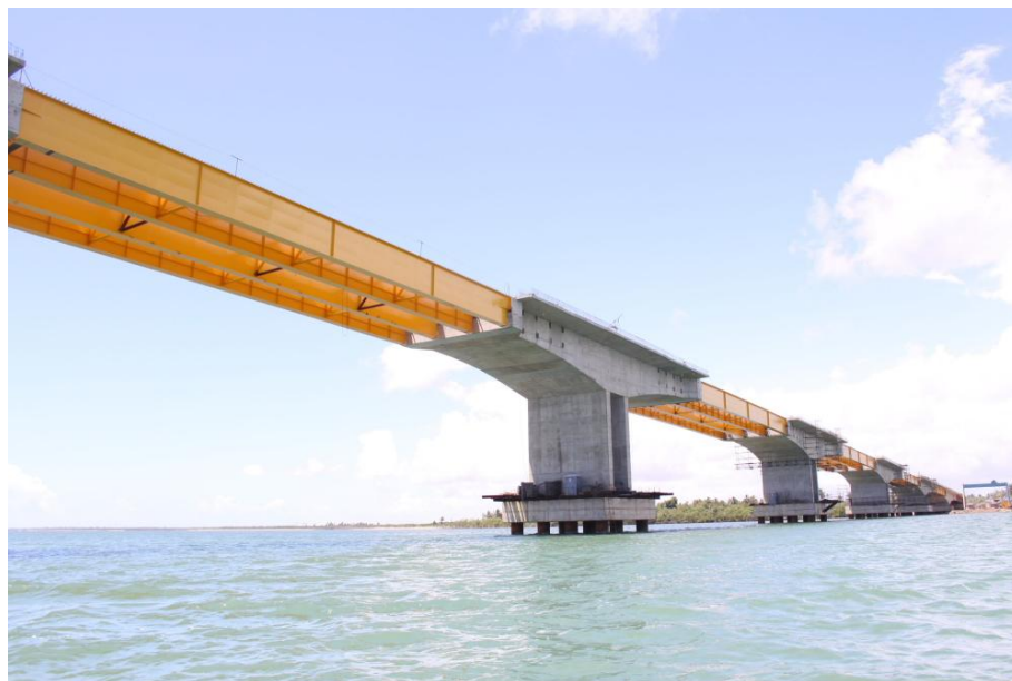
Figura 4-1: Ponte Jornalista Joel Silveira, em Aracaju – SE. Exemplo de aplicação de vigas.
