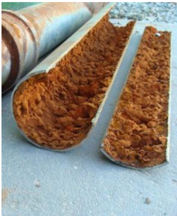
Figura 11 – Tubulação que sofreu incrustação [21]
