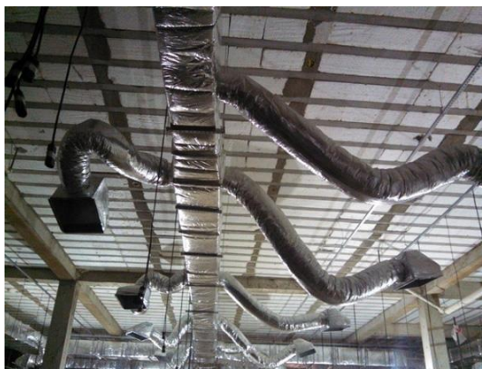
Figura 3.17 – Instalação com duto isolado
