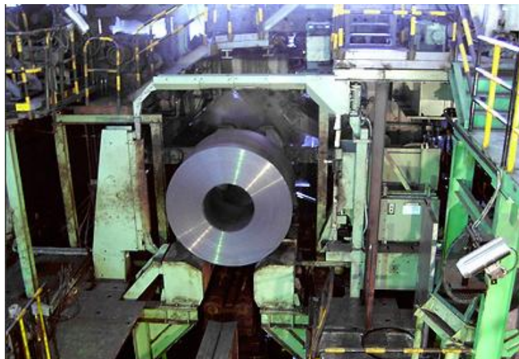
Figura 13 - Bobinadeira. Fonte: Primetals
