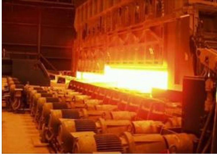
Figura 5 - Forno de reaquecimento. Fonte: World Steel Association
