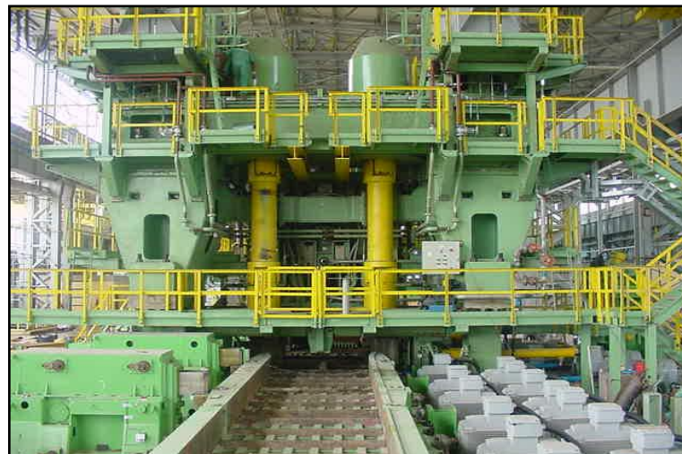
Figura 8 - Laminador de desbaste reversível. Fonte: SMS Siemag
