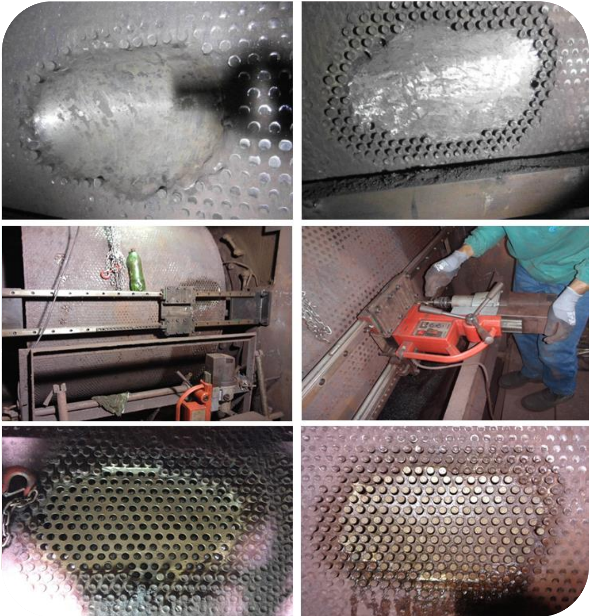
Figura 20 - Procedimento para furação e colagem de pinos em regiões mais afetadas Fonte: VALE, 2014.
