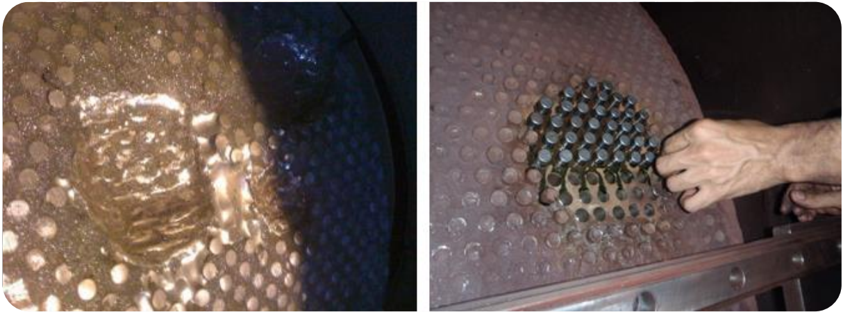
Figura 21 - Recuperação antes (esq.) e depois da furação e colagem (dir.) Fonte: VALE, 2014.
