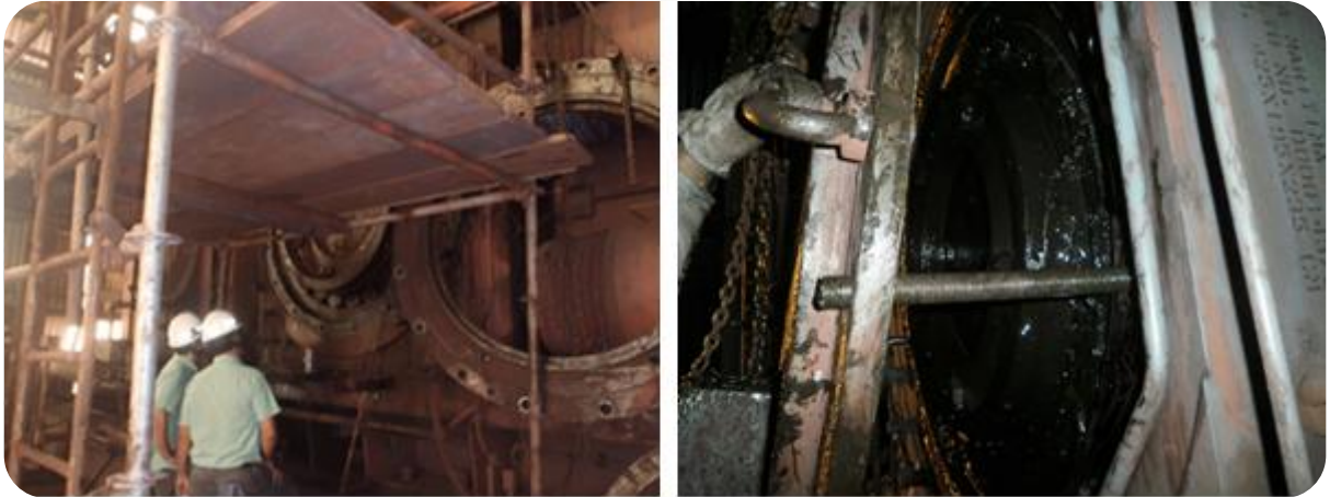
Figura 16 - Visão do acesso ao rolamento e seu estado desejável Fonte: VALE, 2014.
