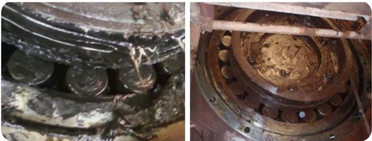
Figura 13 - Rolamento com deficiência de lubrificação (esq.) e após limpeza (dir.) Fonte: VALE, 2014.
