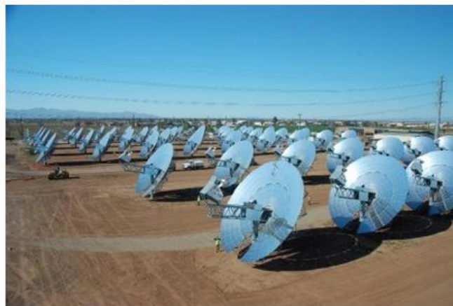
Figura 23 - Maricopa Solar Project, Peoria, Arizona - EUA. Fonte: Bellows (2009)
