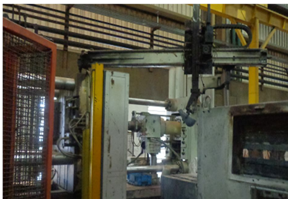
Figura 32 – Transporte do alumínio retirado do forno
