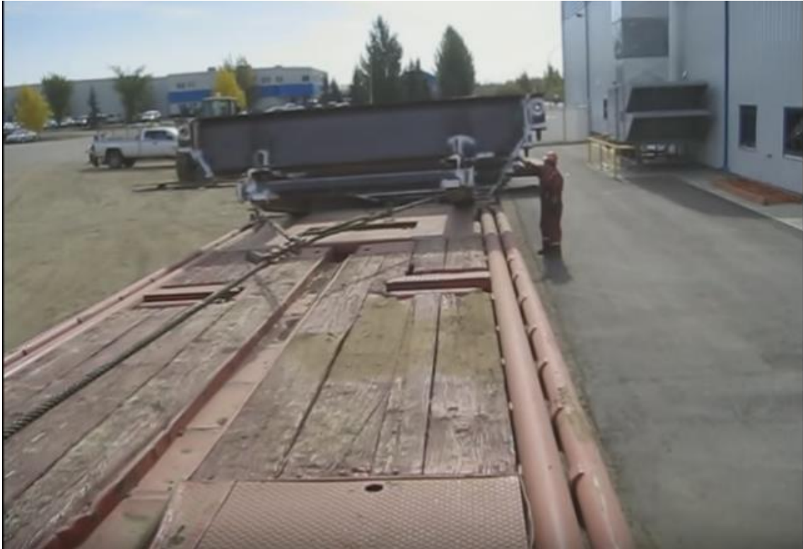
Figura 31 - Situação de carregamento pelo uso de dois cabos
