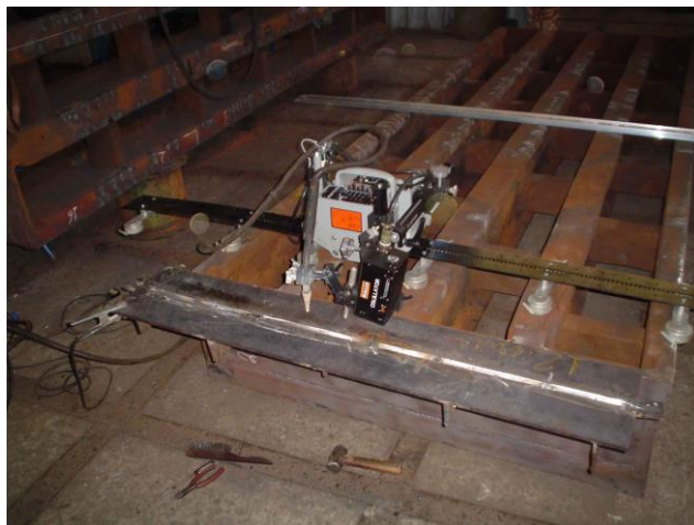
Figura 5 – Apresenta a máquina de corte montada para a soldagem
