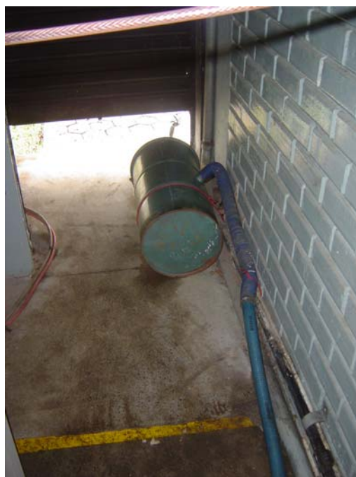
FIGURA 40 : Latão para absorção do barulho.
