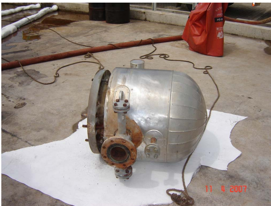
Figura 8 – Cabeçote de um trocador de calor casco-tubo retirado para manutenção.
