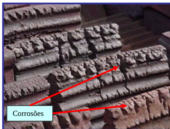
Figura 89 – Corrosões que aparecem no topo dos blocos de aço do carro grelha.
