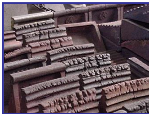
Figura 90 – Corrosões que aparecem no topo dos blocos de aço do carro grelha.
