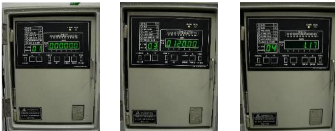
Figura 34,35 e 36: Procedimento de programação do medidor de vazão para Litros por segundo.
