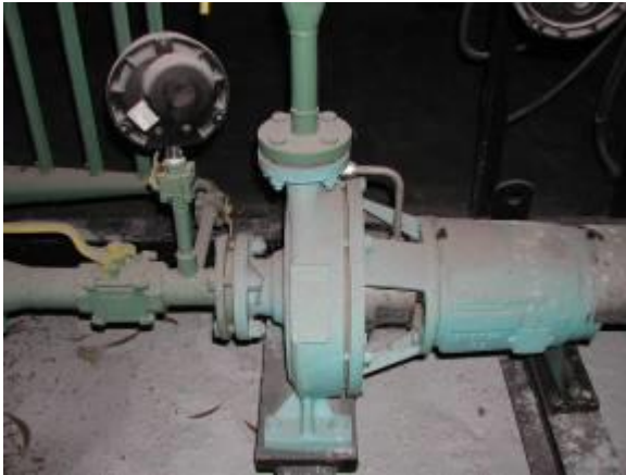
Figura 19. Bomba Centrifuga
