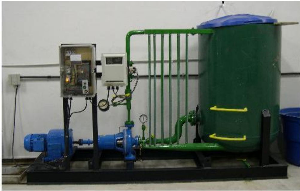
Figura 37. Bancada para Teste de Bombas Centrifuga Radial, completamente recuperada.
