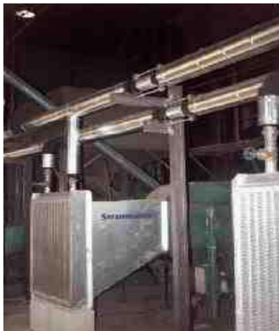
Figura 6.02 – Trocador de calor utilizando água quente
