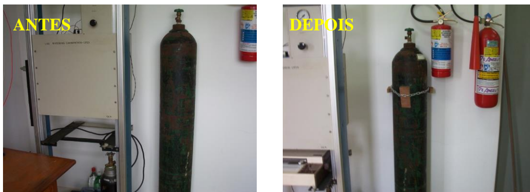
Figura 23 - Fixação do cilindro de oxigênio.
