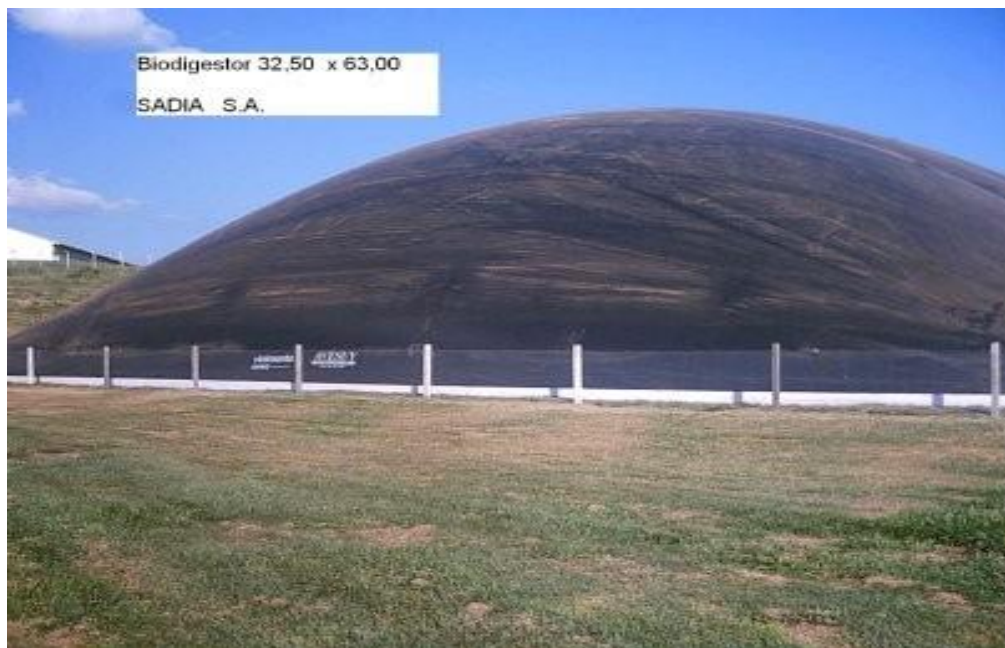
Figura 28 – foto de um Biodigestor com gasômetro de vinimanta.
