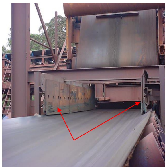
Figura 13 - Chute de Descarga
