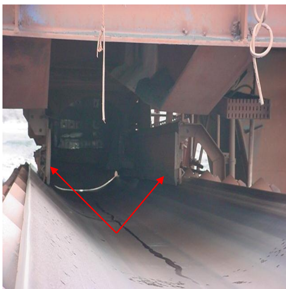
Figura 12 - Chute de Alimentação
