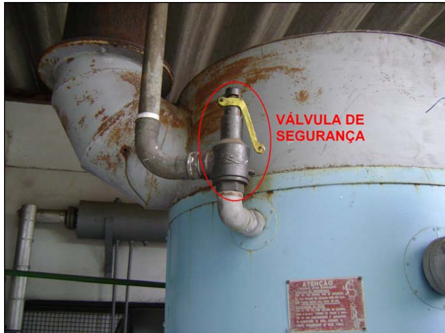
Figura 18 - Válvula de segurança.
