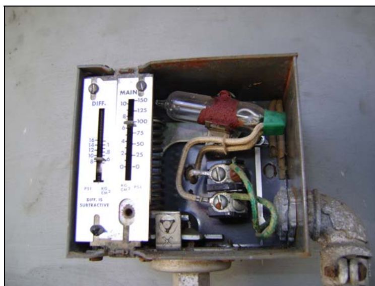
Figura 17 - Pressostato.
