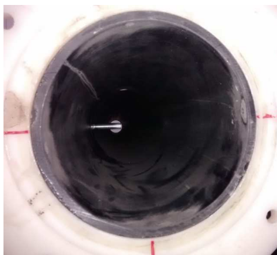
Figura 21. Tubo de Pitot Industrial inserido na tubulação anteriormente ao teste.
