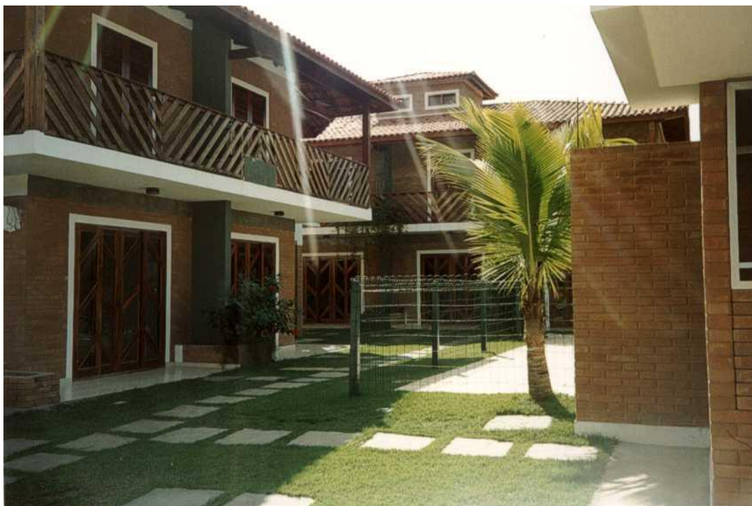
Figura 35 - Casas Construídas com Tijolos de Solo-Cimento
