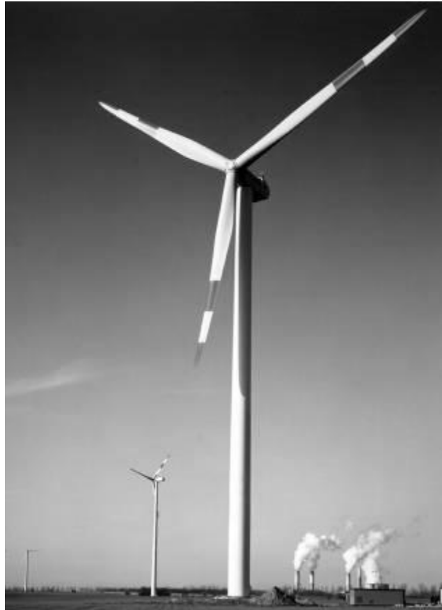
Figura 7 – Turbina eólica moderna Nordex 2,5 MW, com 80 metros de altura e de diâmetro do rotor
