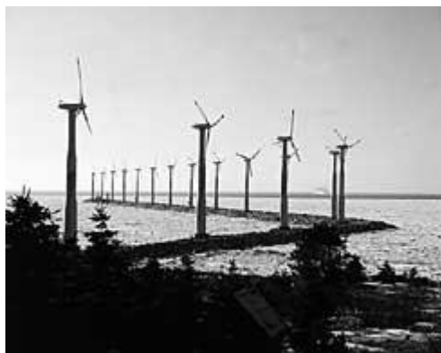
Figura 22 – parque eólico de Ebeltoft, Dinamarca
